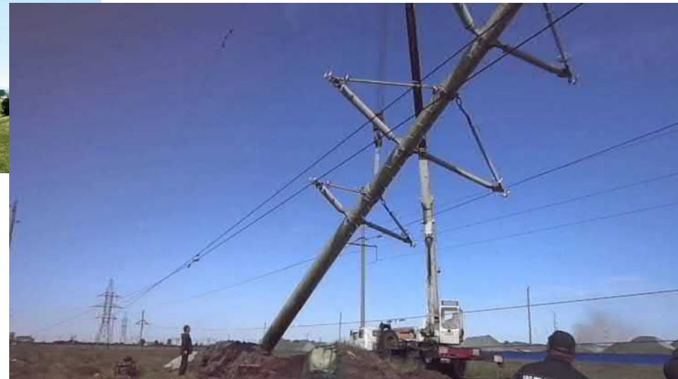
Установка опор из композитных материалов
